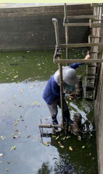
曝氣設備檢修作業
